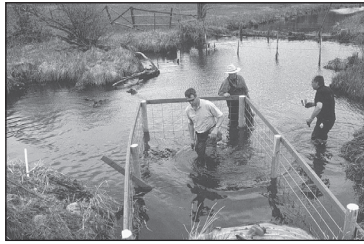
For-dammer — med robust konstruksjon og tilpasning av formen til formen på bekken.
